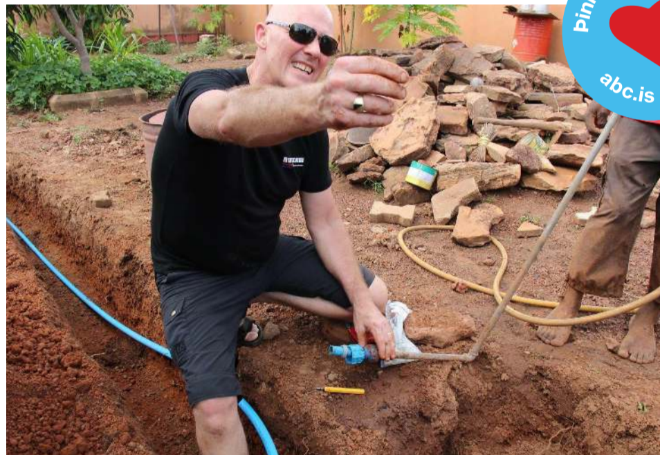
Haraldur kominn í pípuþagnir fyrir vatnsveituverkefnið í Búrkína Fasó.
